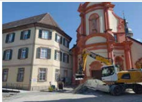
wurde eine Musterfläche für das zu verlegende Pflaster erstellt. Muschelkalk Natursteine wurde gespalten und gesägt um sie in verschiedenen Größen einzubauen. 900 m<sup>2</sup> Natursteinpflaster verlegten wir als aufwendigen Passé-Verband und 250 m<sup>2</sup> im Reihenverband. Zudem entstand ein Aufenthaltsplatz mit einem Brunnen sowie Sitzmöglichkeiten.
