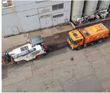
wird eingebaut. Dies ist innerhalb von ein oder zwei Tagen möglich. Wenn die Bauzeit eine Woche umfassen darf, werden Bereiche bspw. unter Silos durch großformatige Betonplatten verstärkt. Beton-Fertigteile werden auf einen verstärkt aufgebauten Untergrund eingebracht. Die Wasserableitung ist in den sanierten Bereichen zu überdenken. Einlaufrinnen die einfach zu reinigen sind, erleichtern den alltäglichen Betrieb der stark frequentierten Flächen.
