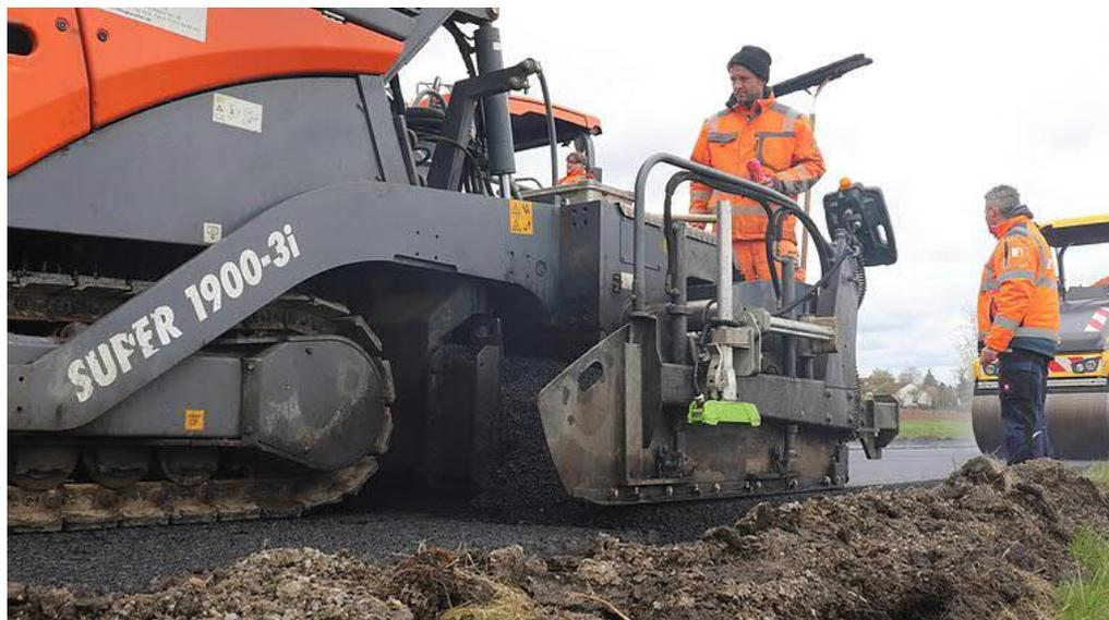
Foto: Eike Lenz | Der heiße Asphalt wird eingebaut und vorverdichtet. Anschließend kommt er unter die schweren Walzen.
