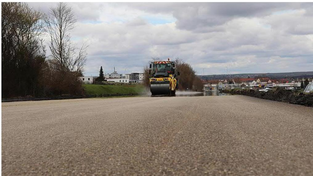
Foto: Eike Lenz | Schwere Walzen rollen über die neue Fahrbahndecke der B 8. Mit dem Teilstück in Richtung Kitzingen begannen die Straßenbauer ihr Werk.
