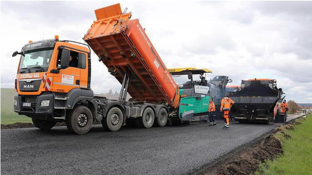
Foto: Eike Lenz | Logistik ist alles auf einer Baustelle wie dieser. Ein Kipplaster bringt vom Mischwerk Nachschub an frischem Asphalt.
