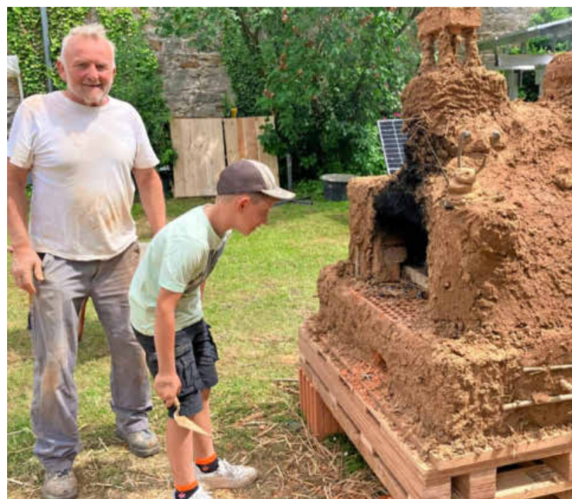
Ekkehard Holl hat mit Großneffe Lenny einen Lehmofen gebaut. Am Samstag wird eingeeizt. Die Besucher sind sehr interessiert an ökologischen Baustoffen.
