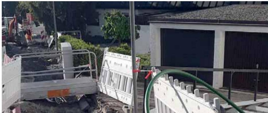
Ab April 2019 wurde die Augelbaumstraße in Leingarten saniert. Neben dem Neubau einer ca. 2.800 m<sup>2</sup> großen Asphaltdeckschicht, lag die Hauptarbeit in der Gehwegsanierung und der Verkabelung. Dabei wurde für die NHF, auf einer Strecke von über 400m, eine neue Stromtrasse, sowie eine Glasfaserleitung mit
